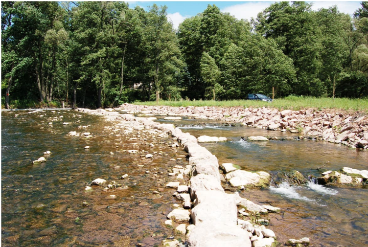
Im Jahr 2008 nach Abbruch der Wehranlage neu angelegte Sohlgleite
