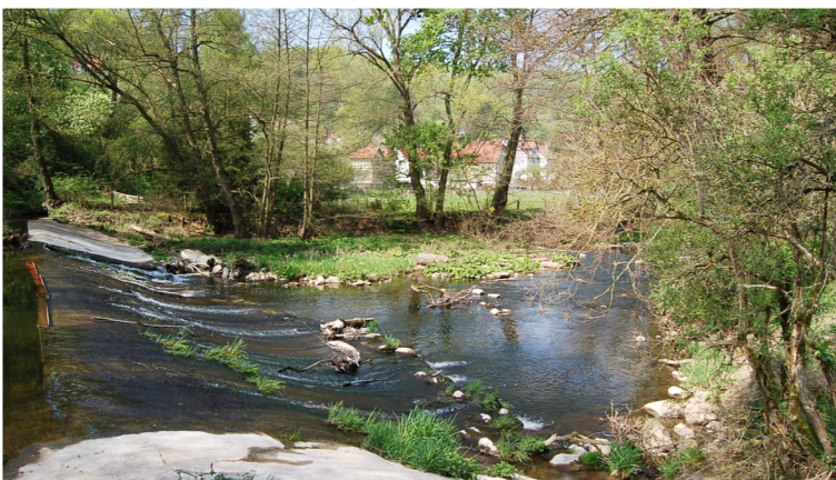
2007: Wehranlage, die vollständig zurückgebaut wurde
