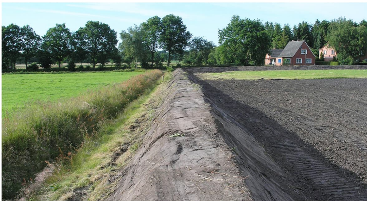
Frisch aufgeschütteter Wallkörper vor der Bepflanzung
